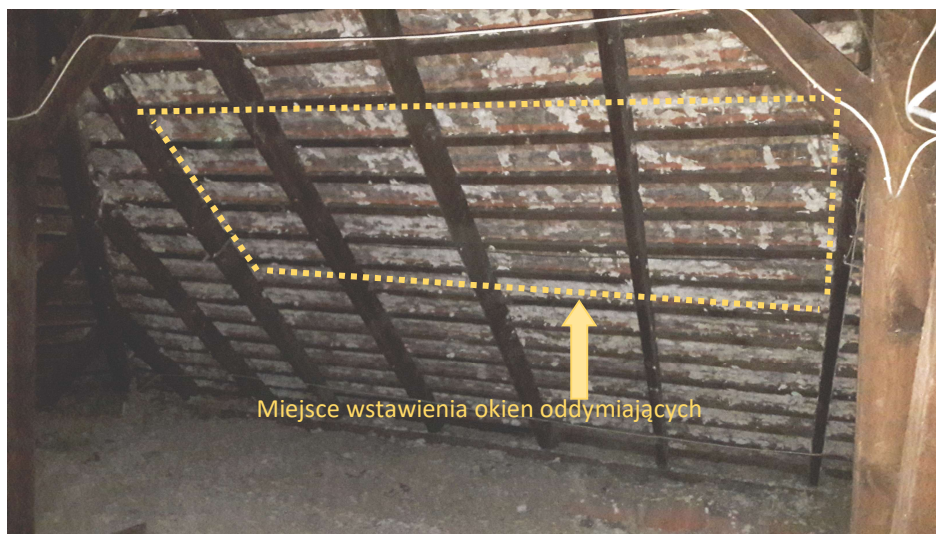
Widok na połać dachową znajdującą się nad klatką K4.
