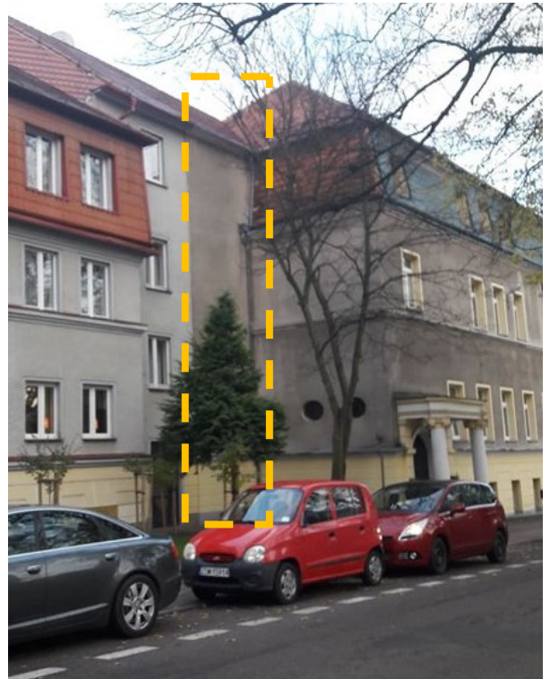
Klatka schodowa K4 objęta projektem.
