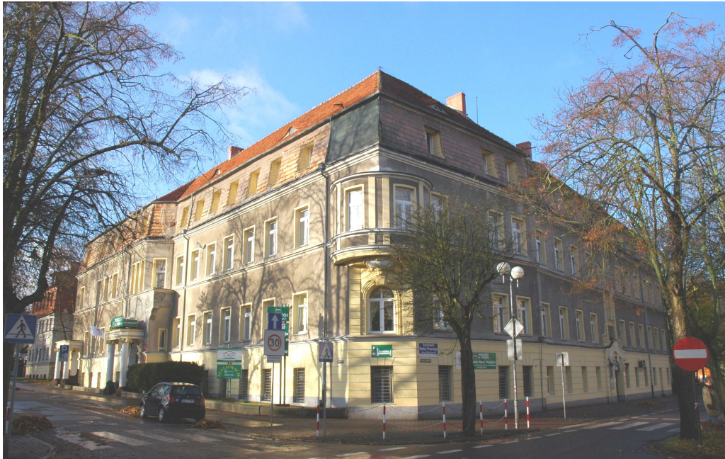
Widok na budynek od strony północno-wschodniej (część stara), źródło:
