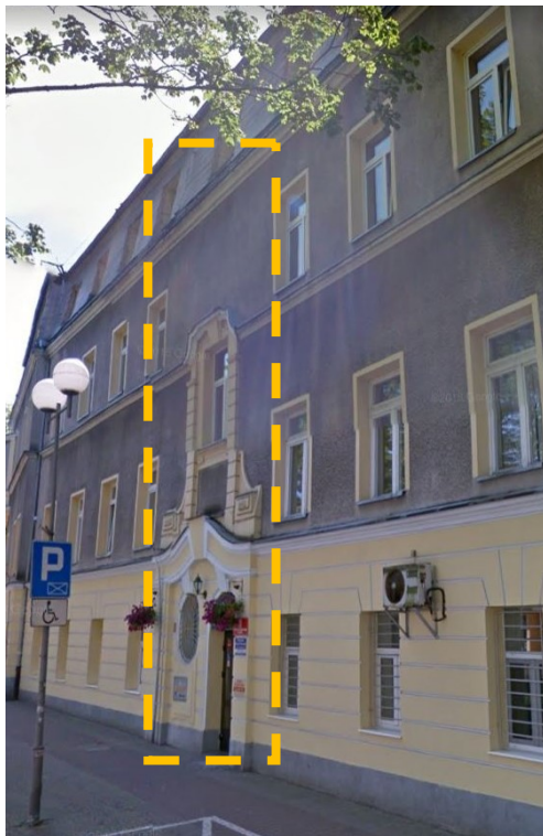
Klatka schodowa K3 objęta projektem.
