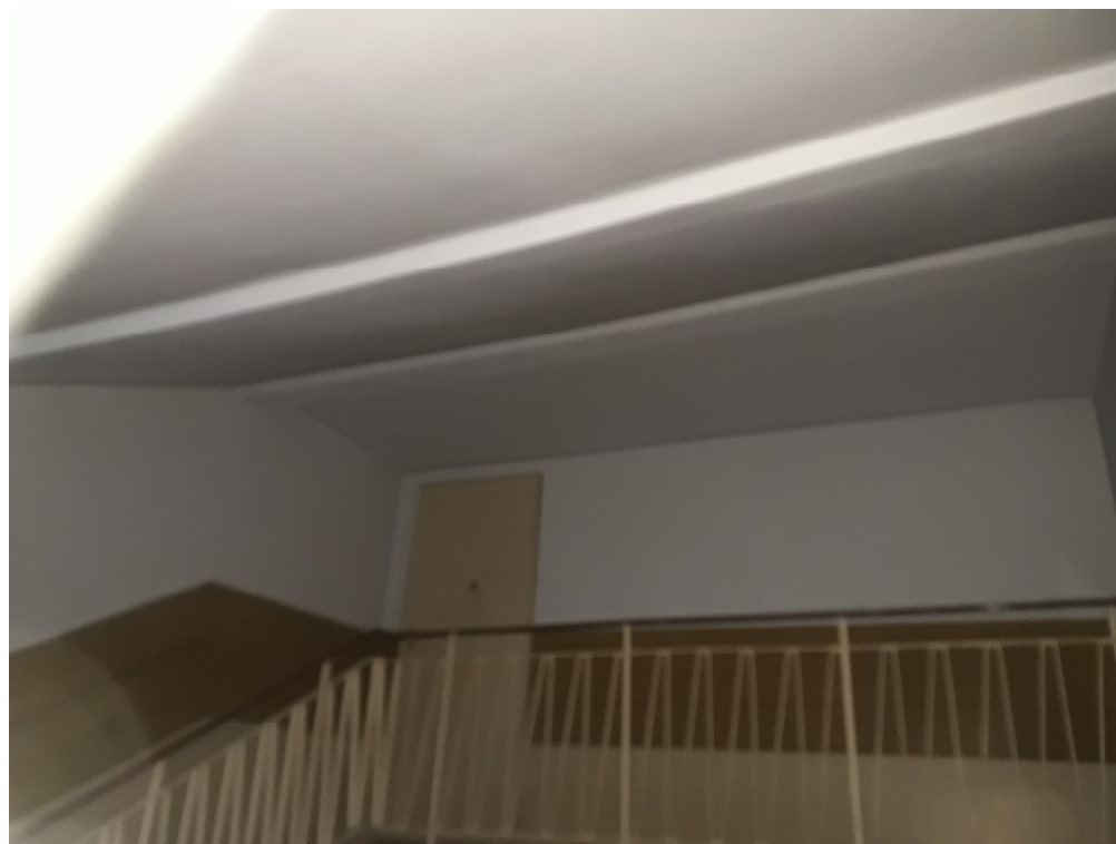
Fragment stropu do rozbiórki klatce nr 3
